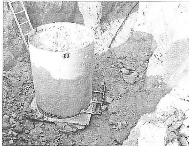
Vue d'un lysimètre et de son système de collecte d'eau. Epuvaleau asbl a coordonné l'installation des lysimètres. (photos Epuvaleau)
